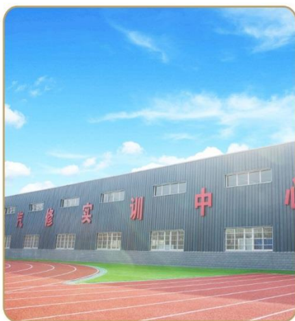
▲ 学校汽修实训楼
